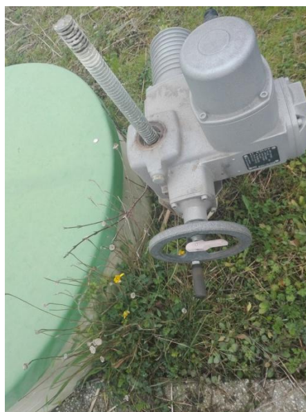
Slika 6: Auma elektro pogon
