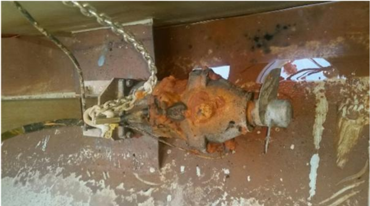
Slika 5: Postojeće stanje mješača
