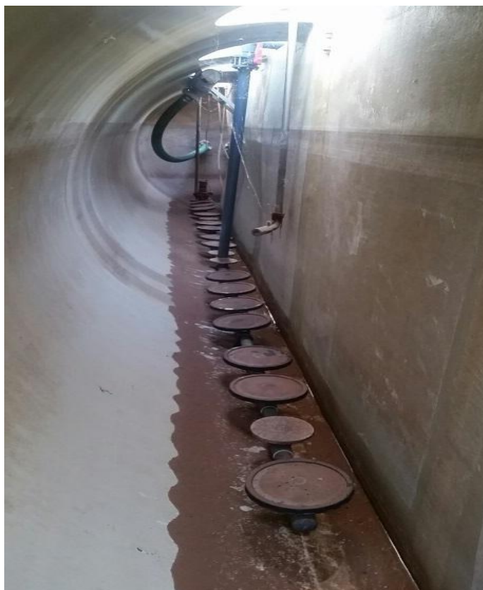
Slika 10: Linija sa membranskim difuzorima-postojeće stanje
