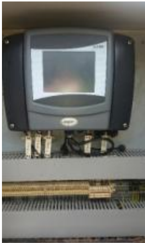
Slika 7: Displej kontrolera sonde za kiseonik i mutnoću aktivnog uglja
