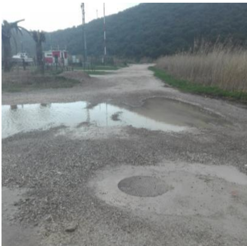
Slika 1: Položaj postojeće pumpne stanice PS "Jaz"
