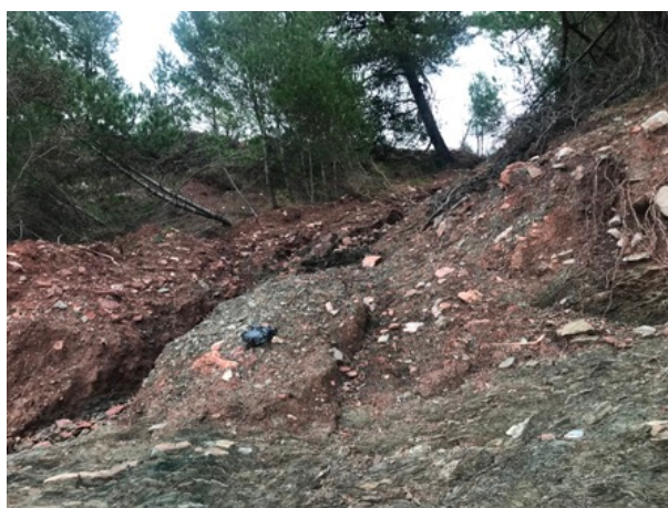
Slika 2.7. Zaleđe plaže sa vidnom erozijom tla
