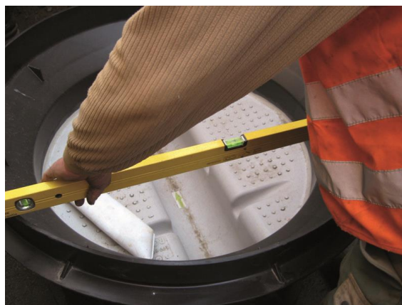
Slika 3 i 4: Kontrola položaja odvoda
