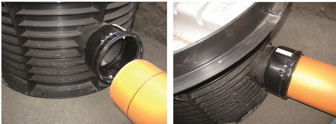
Slika 5 i 6: Izvođenje spoja šahta sa PVC cijevima
