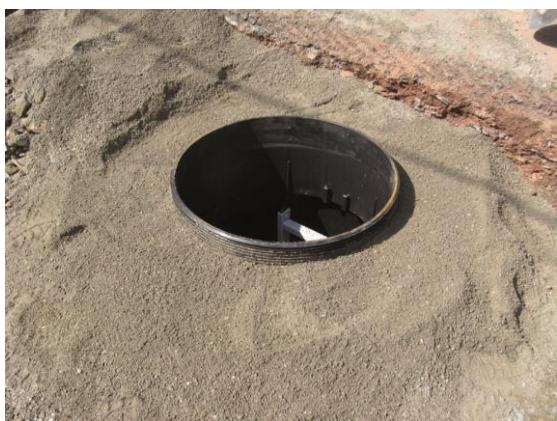
Slika 9 i 10: Postavljanje betonskog prstena za prihvatanje opterećenja
