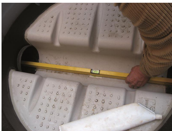
Slika 3 i 4: Kontrola položaja odvoda
