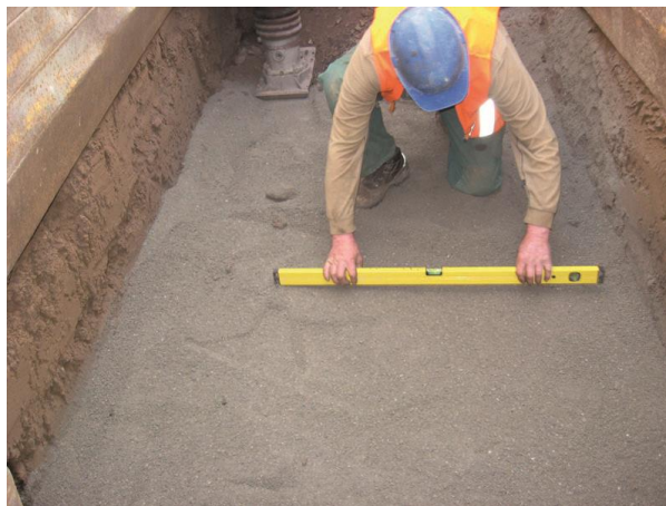
Slika 1 i 2: Priprema podloge za polaganje šahtova
