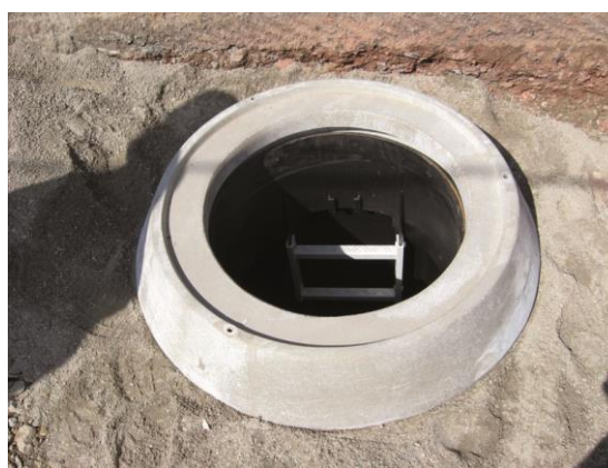
Slika 9 i 10: Postavljanje betonskog prstena za prihvatanje opterećenja
