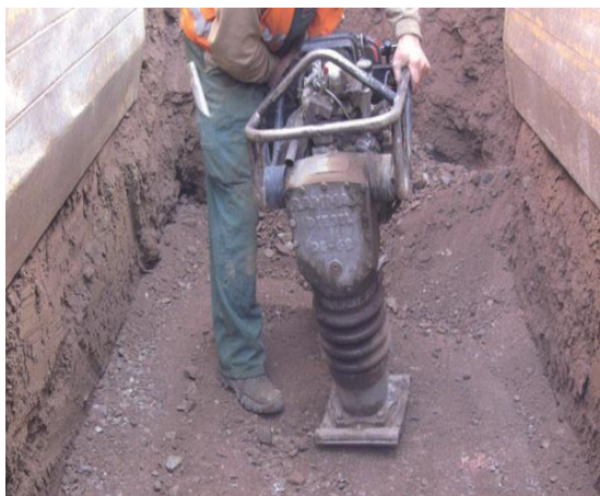
Slika 1 i 2: Priprema podloge za polaganje šahtova
