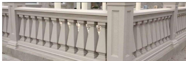
Prefabrikovani betonski elementi u bijeloj boji
