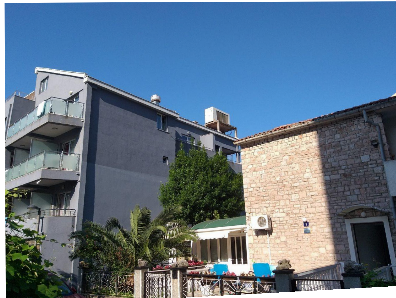
01-PRIKAZ-2 POSTOJECE STANJE-prije intervencije
