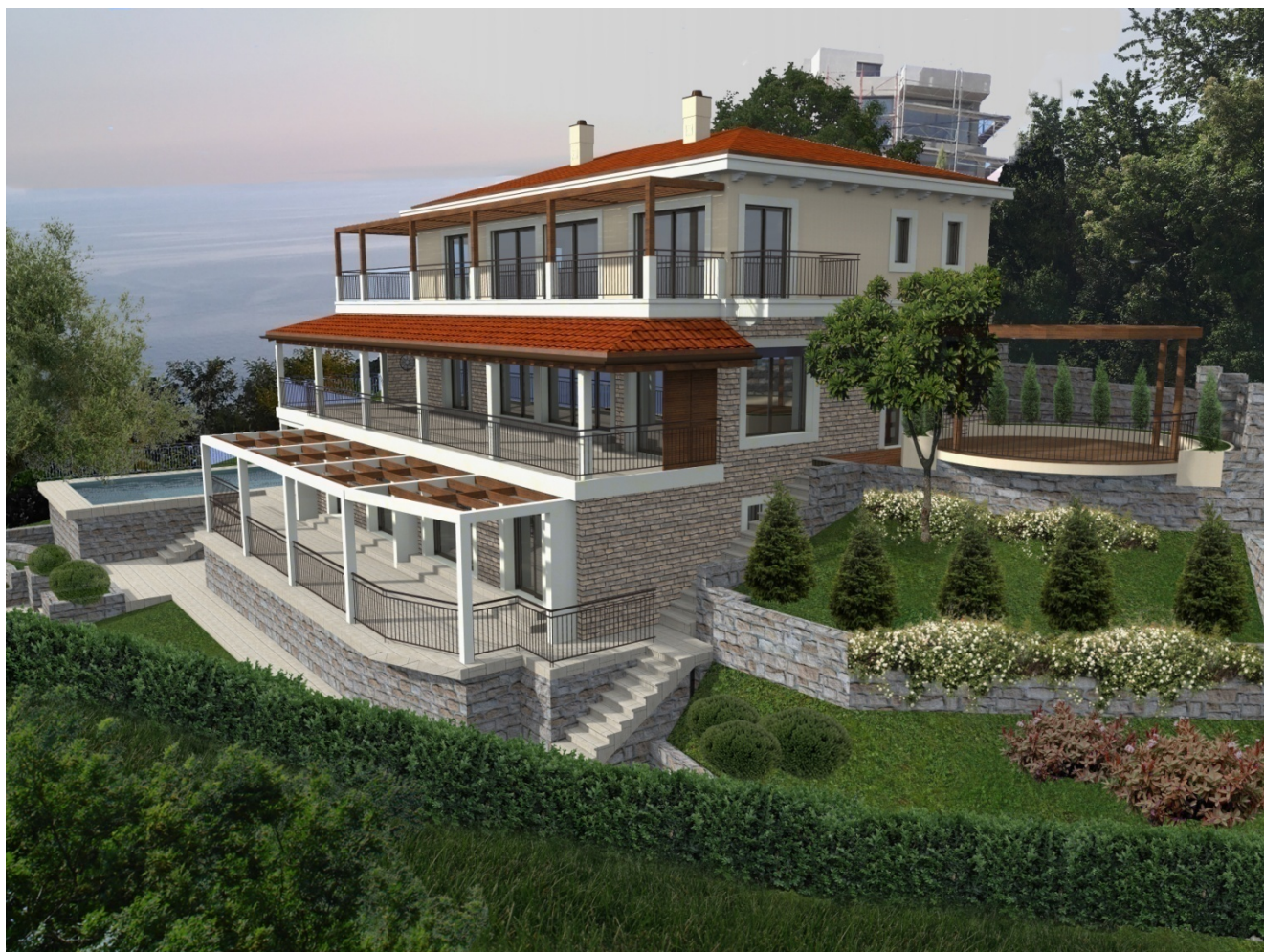
sl. 1 IZGLED OBJEKTA SA JUGOISTOČNE STRANE
