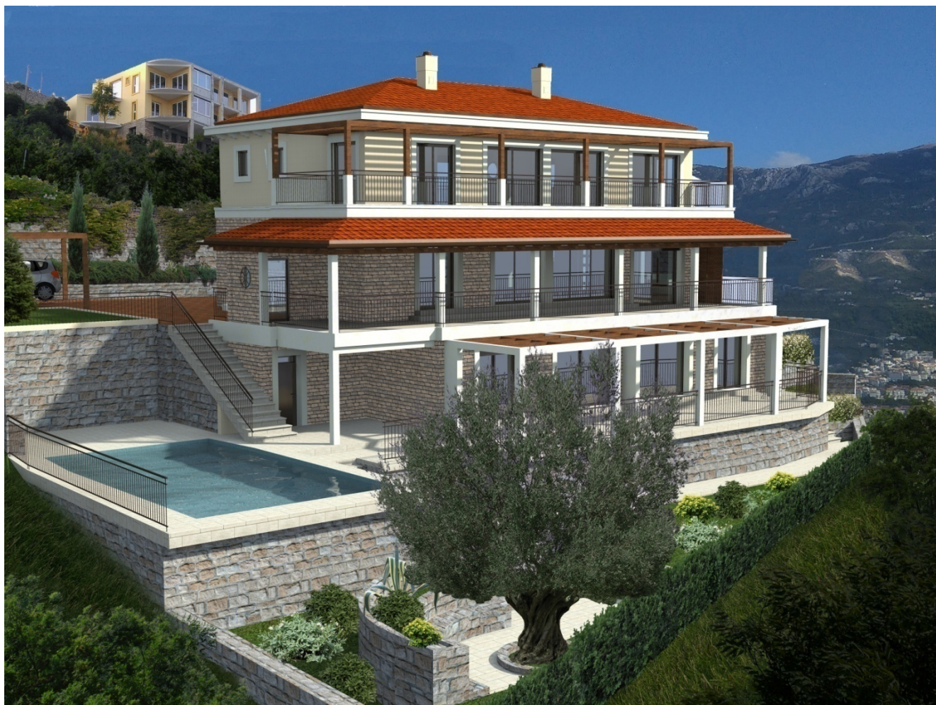
SI. 2 IZGLED OBJEKTA SA JUGOZAPADNE STRANE
