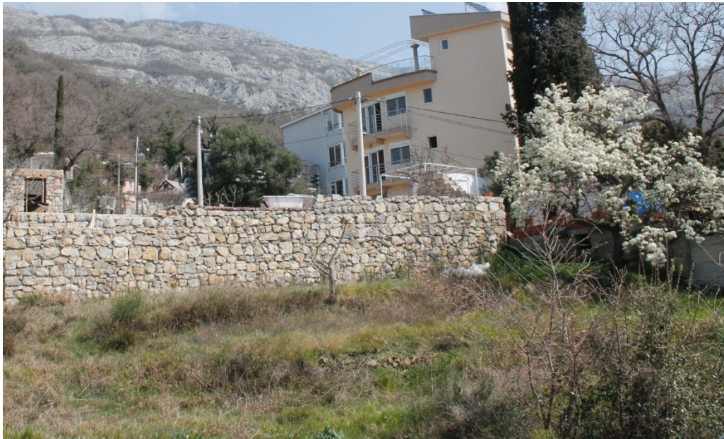
Postojeće stanje na parcelama 317 i 314/9
