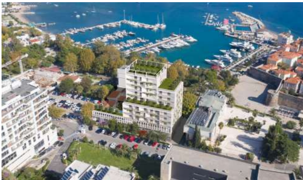
Slika 6. Maketa objekta na lokaciji
