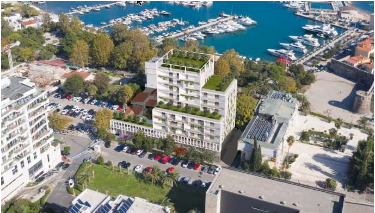
Slika 3. Maketa objekta na lokaciji
