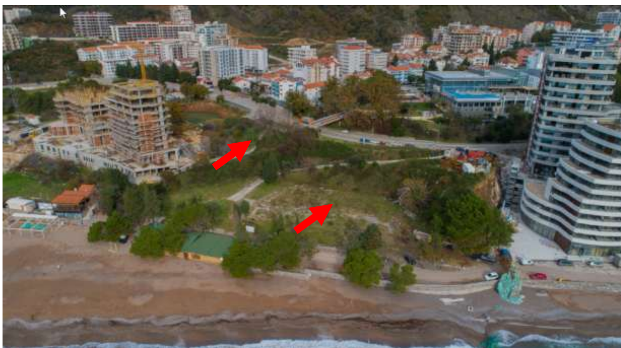
Slika 2. Lokacija objekata (označen strelicom) sa užom okolinom
