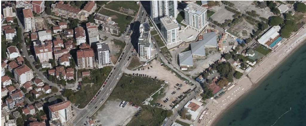
Slika 2.2. Izgled lokacije sa okruženjem
