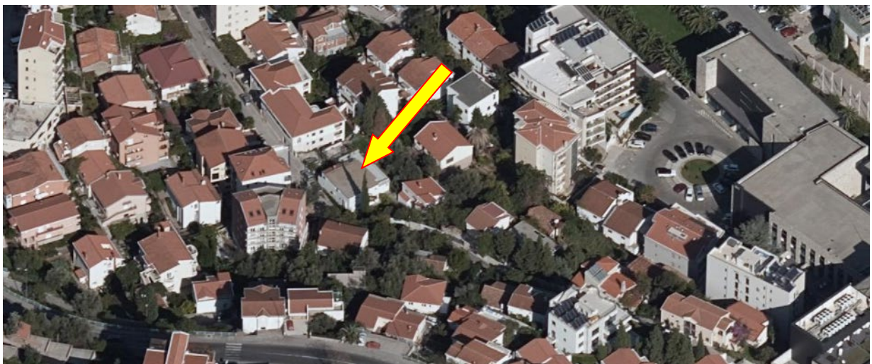
Slika 2.2. Izgled lokacije sa okruženjem
