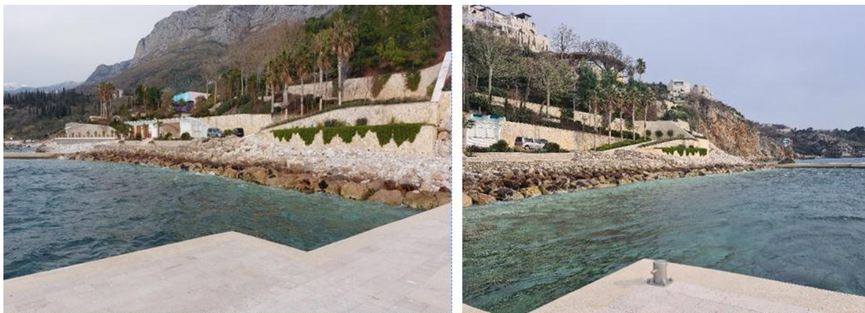
Slika 12. Izgled predmetne lokacije
