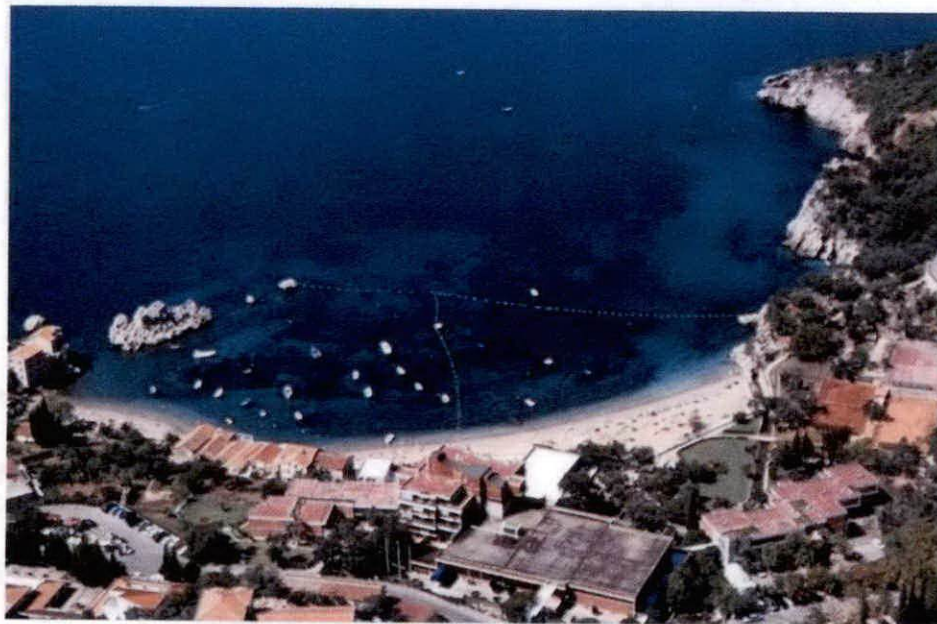
Slika 2. Lokacije plaže Pržno sa užom okolinom
