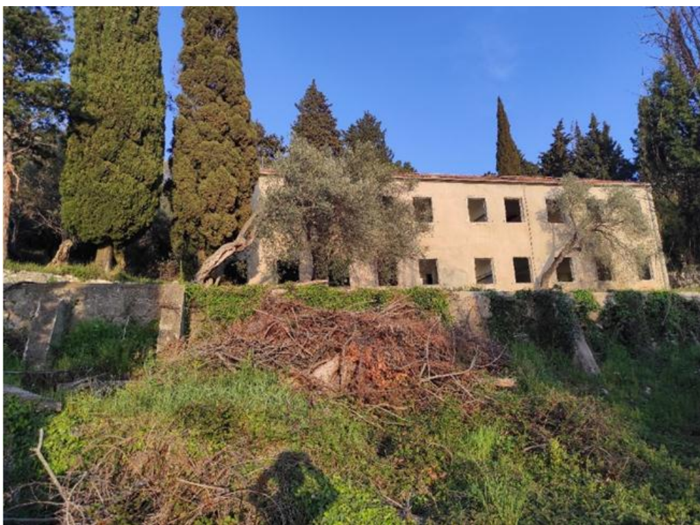
Slika 8. Pogled na jednu od zgrada u sastavu kasarne
