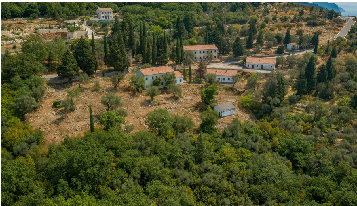
Slika 3. Postojeće stanje lokacije
