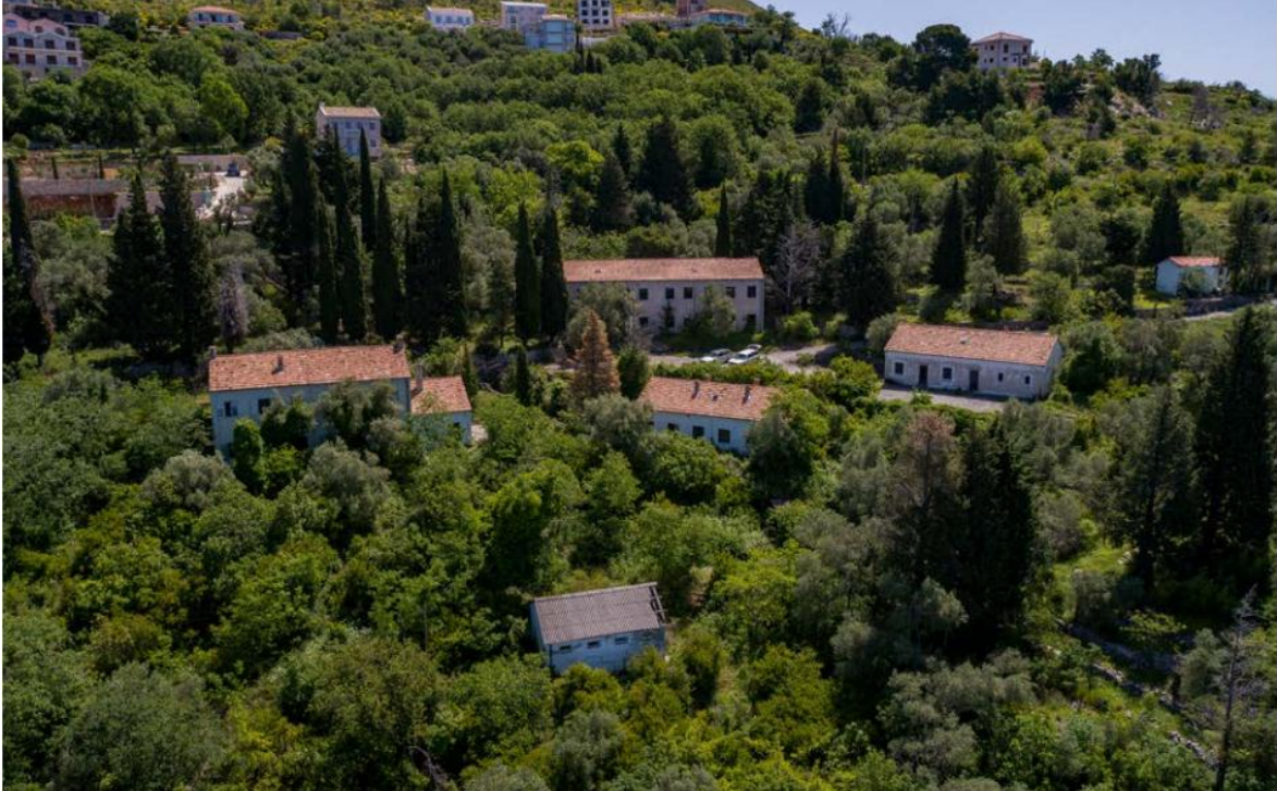
Slika 3. Postojeće stanje lokacije
